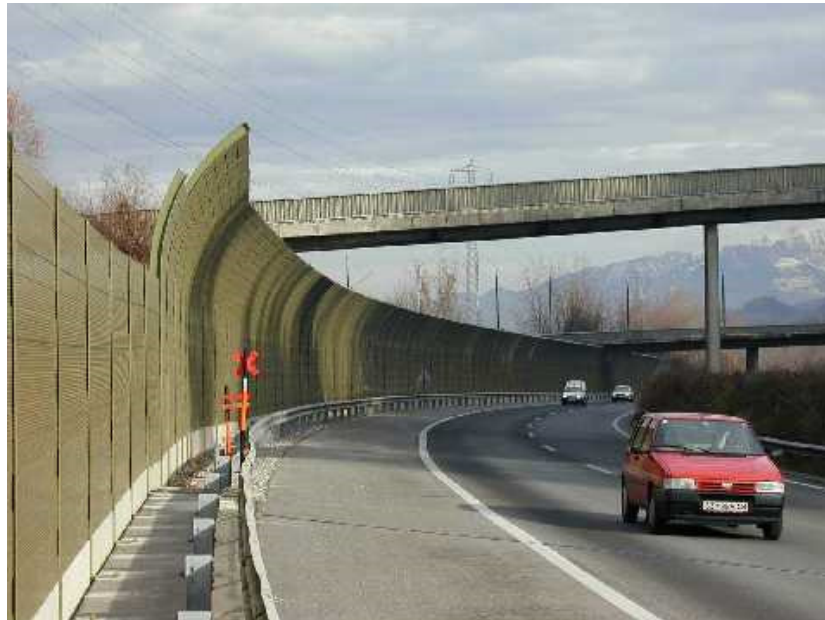
Fotografia 2 - Pareti antirumore su un'autostrada in Austria http://www.tirol.gv.at/uploads/pics/abb004wiesengasse3.jpg
