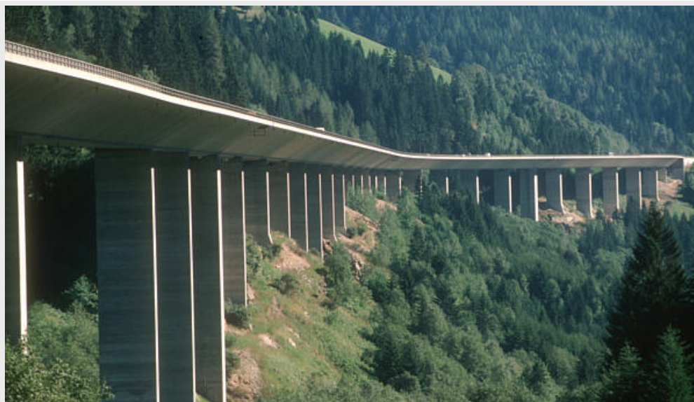
Fig. 6 – Ponte sulla Liesertal sul percorso della A10
